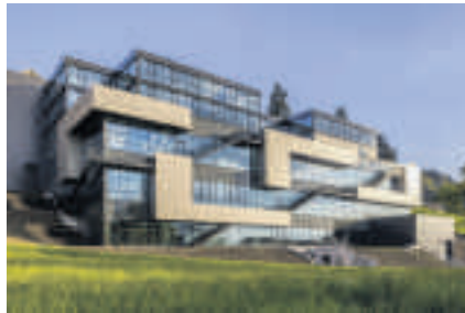
Neubau JUST Schweiz AG Walzenhausen
