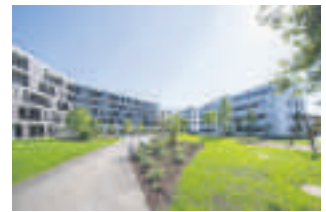
Neubau «36.5 Grad» Heerbrugg
