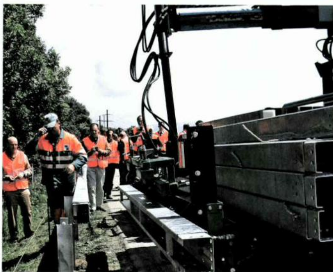
Ohne manuelles Hochheben: Die Pfähle werden per Knopfdruck in Position gebracht.
