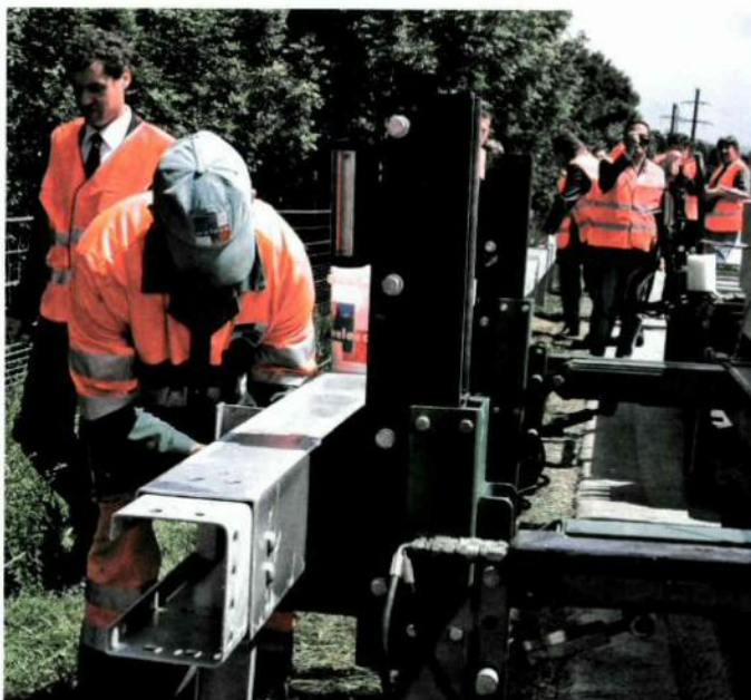
Die Elemente sind rasch montiert. Fotos: Martin A. Waiser
